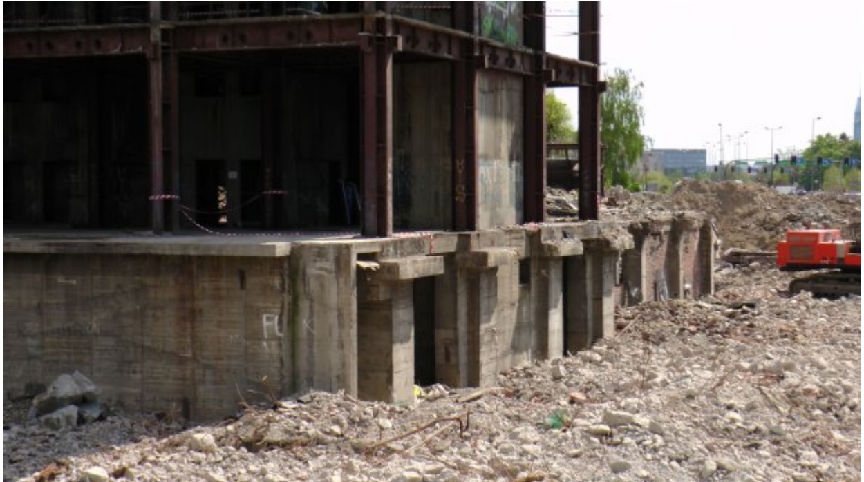
Rozbiórka Szkieletora. Maj 2016 (Fot. Dorota Gut)
