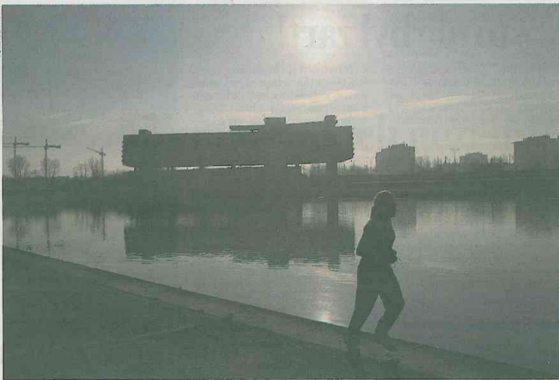
Aby hotel Forum mógł zostać wyburzony, decyzję musł podjąć wojewódzki konserwator zabytków
