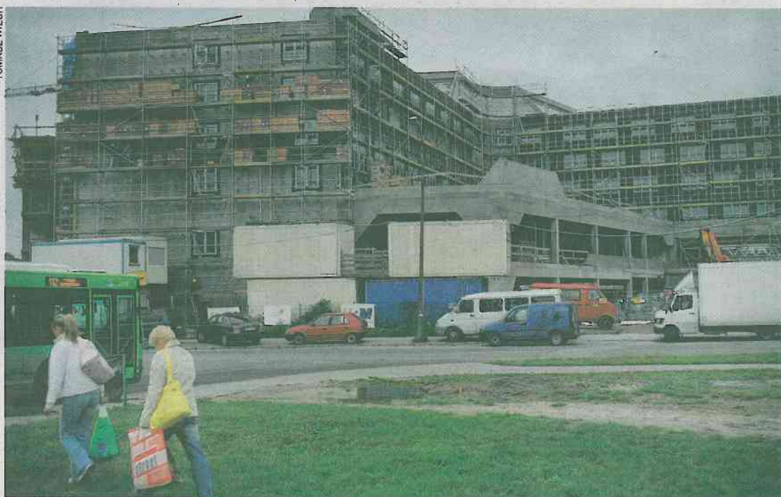
Wczoraj zakończono pierwszy etap budowy hotelu Park Inn
