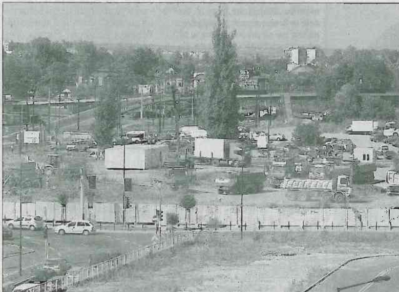
W tym miejscu (róg ul. Szlak i Pawiej) powstają dwa hotele
