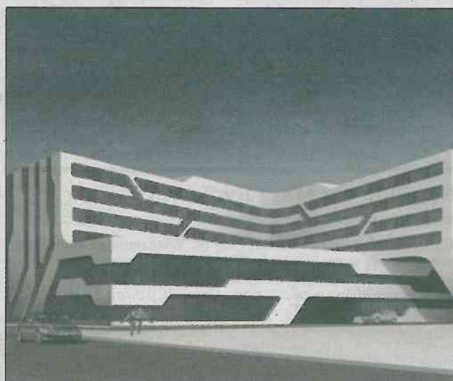
Hotel S. O. F. przy ul. Monte Cassino (trwa budowa)
