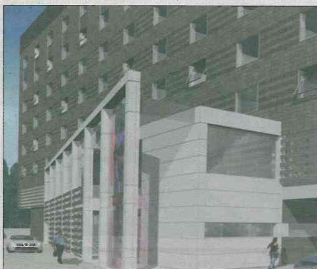
Hotel „Zakrzówek” przy ul. Konopnickiej (w budowie)
